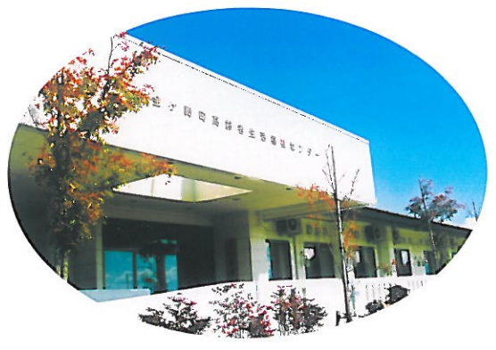
■金ヶ崎町高齢者生活福祉センター さつきホーム
